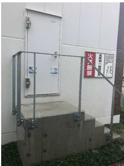
■ 塀に設けた防水扉
